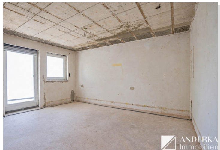
Baufortschritt Wohn- und Esszimmer
