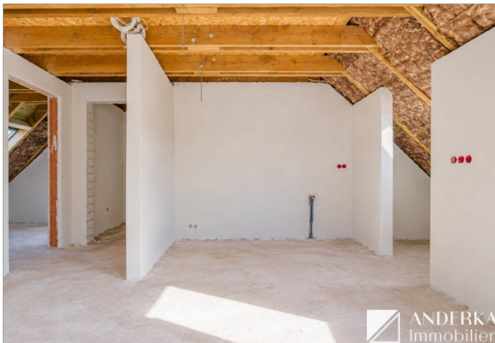
Baufortschritt offener Ess- und Kochbereich
