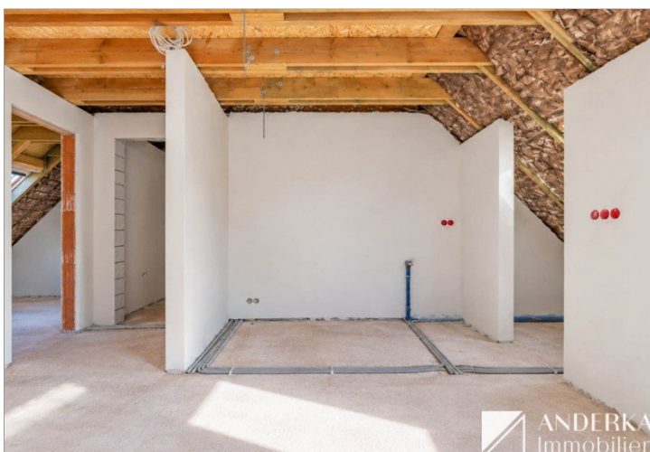
Baufortschritt offener Ess- und Kochbereich
