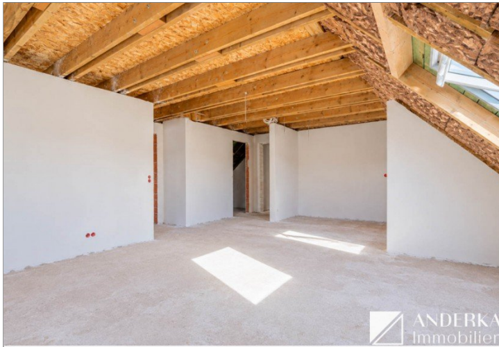
Baufortschritt offener Wohn- / Ess- und Kochbereich
