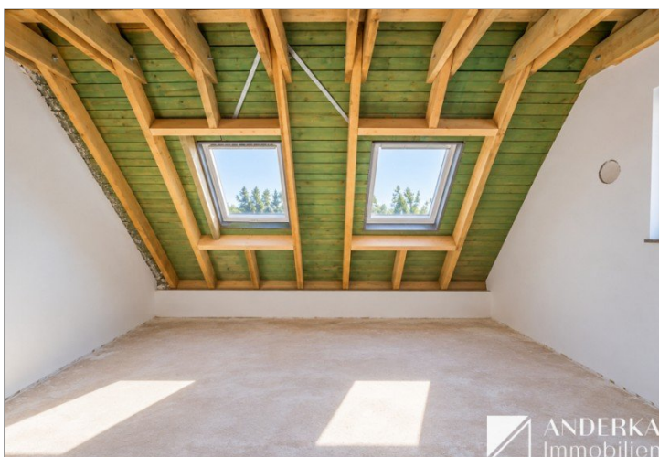
Baufortschritt Wohn- / Ess- und Kochbereich
