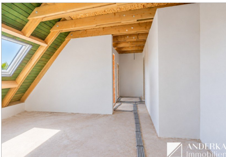
Baufortschritt Wohn- / Ess- und Kochbereich
