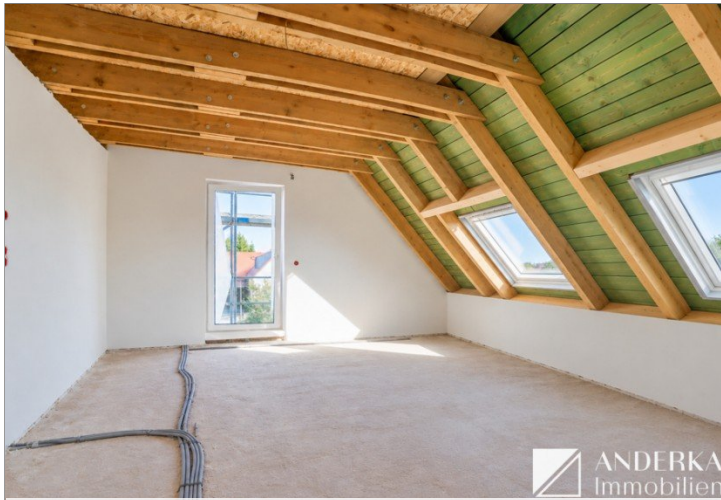
Baufortschritt Wohn- / Ess- und Kochbereich
