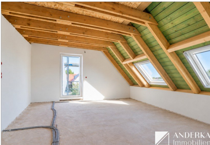
Baufortschritt Wohn- / Ess- und Kochbereich
