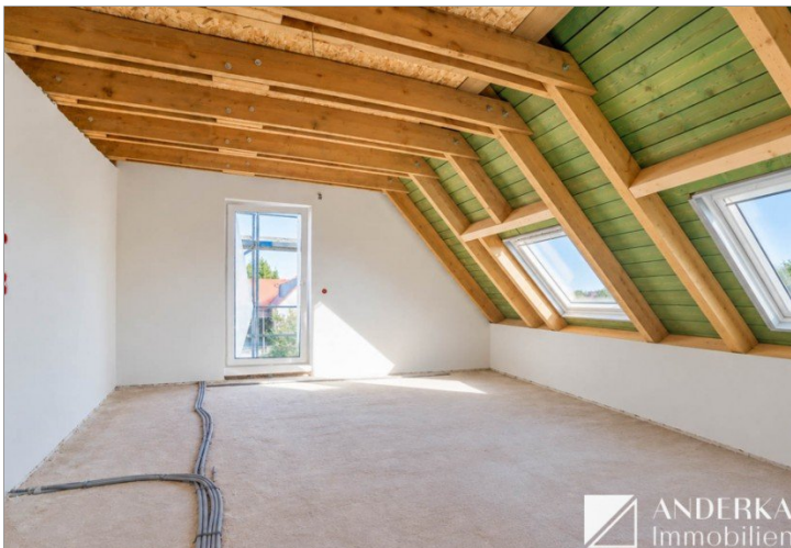
Baufortschritt Wohn- / Ess- und Kochbereich
